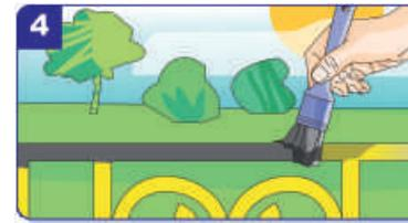
4 Die Endlackierung erfolgt mit individuellen ausgewähltem Lack für Eisen- und Stahlflächen. Bei anderen Metallen, wie z.B. Kupfer, verzinkten Produkten, Heizkörpern etc. sollten die dafür vorgeschriebenen Lackprodukte verwendet werden.
