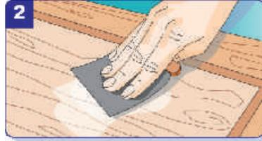
2 Die Holzfläche mit 180er Schleifpapier anschleifen. Unebenheiten oder Beschädigungen mit Spachtelmasse ausfüllen. Nach dem Trocknen diese Stellen nochmals überschleifen.
