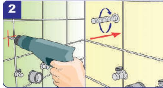
Für die Bohrungen (mind. 85 mm tief) sollte ein Stein-bohrer verwendet werden. Beim Durchbohren der Fliese mit langsamer Drehzahl und ohne Schlag arbeiten. Die Stockschrauben werden mit dem Gabel-schlüssel in die Dübel eingeschraubt, bis das grobe Gewinde nicht mehr sichtbar ist.
